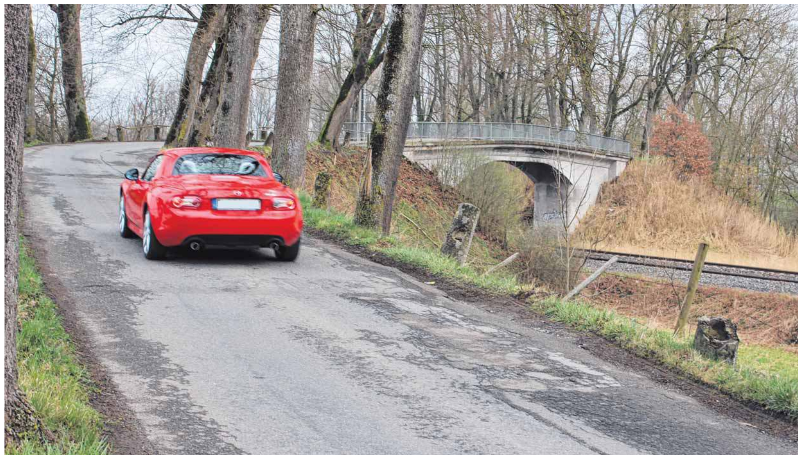
Radler und Fußgänger sollen auch nach der Elektrifizierung der Südbahn über eine Eisenbahnbrücke zwischen den Ortsteilen Zollenreute und Rugetsweiler pendeln.
