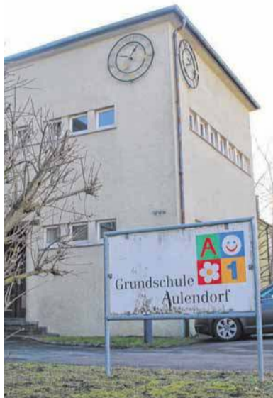
In der Grundschule wird zum Teil die Elektroinstallation neu gemacht, außerdem bekommen die Schüler eine neue Kunststoffbahn mit Weitsprunggrube.
