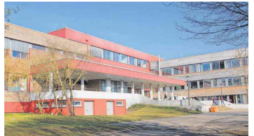
2016 stehen im Schulzentrum einige Sanierungsmaßnahmen an.
