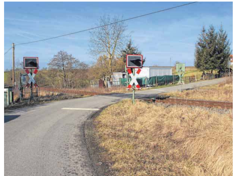
Der nicht mehr zeitgemäße Bahnübergang bei der Dobelmühle wird erneuert.
