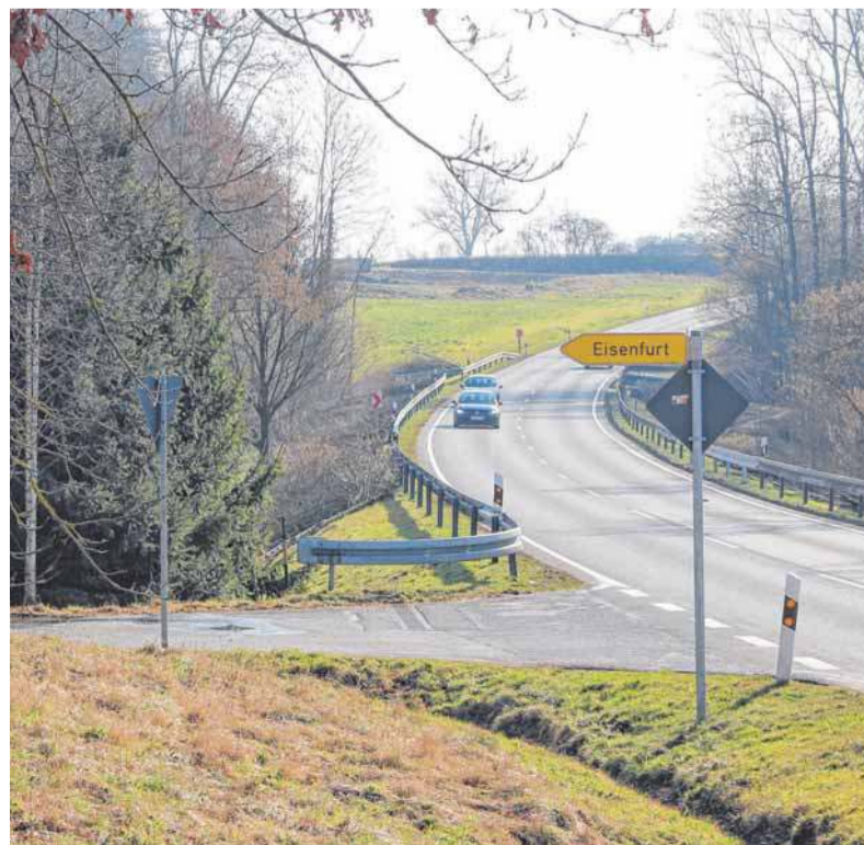
Zwischen der Landesstraße und Eisenfurt wird die Straße erneuert.
