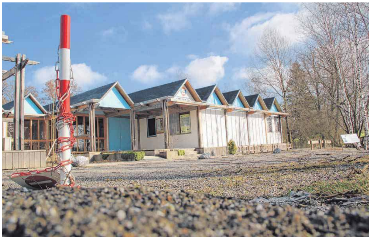
Die 30 Jahre alte Abwasserpumpanlage am Steeger See soll erneuert werden.
