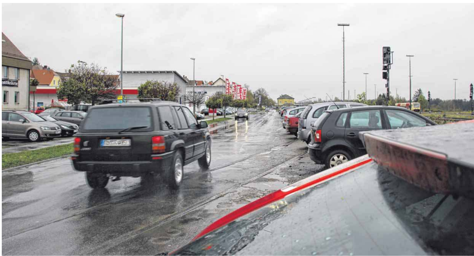
Die Poststraße ist einem schlechten Zustand. Der vorgelegte Plan soll eine Verbesserung der Verkehrssituation bringen. Auch die Straßenführung verlief anders.
